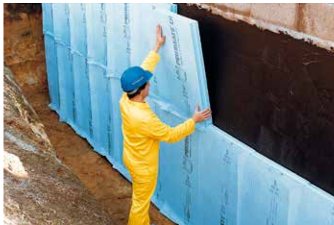
Energiesparen fängt im Keller an: Eine Perimeterdämmung verhindert, dass Wärme ans Erdreich verloren geht. (Foto: djd/FPX Fachvereinigung)
