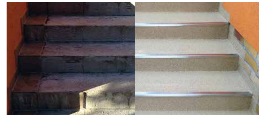
Ein Vorher-Nachher Bilder einer sanierten Treppe von SealUp Abdichtungs- und Dachdecker GmbH
