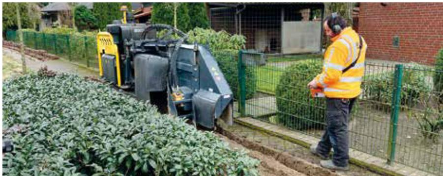
Die Verlegung des Glasfaser-Kabels geschieht mit einem System, welches minimale Schachtarbeiten erfordert. Foto: Deutsche Glasfaser
