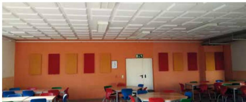
An den Decken sorgen Absorber-Platten für weniger Lärm. Die Rechtecke an den Wänden sind die ebenfalls Lärm schluckenden Absorber-Stoff-Elemente.
