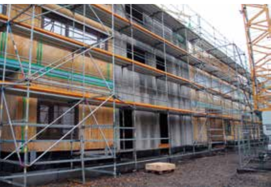
In dem Neubau, dessen Richtfest gefeiert wurde, sollen künftig unter anderem Co-Working-Räume, Werkstätten und Appartements ihren Platz haben.
