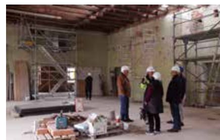
Im Moment ist der ehemalige Saal im Kulturhaus noch eine riesige Baustelle.
