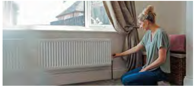
Werden Heizkörper nicht richtig oder unterschiedlich warm und gluckern, ist möglicherweise Luft im System. Foto: DJD/Minol/Getty Images/SolStock
