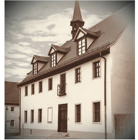
Der Ratskeller war nach der Wende trotz des desolaten Zustandes Treffpunkt zum Aufbau einer Demokratie – heute ist er saniert.
